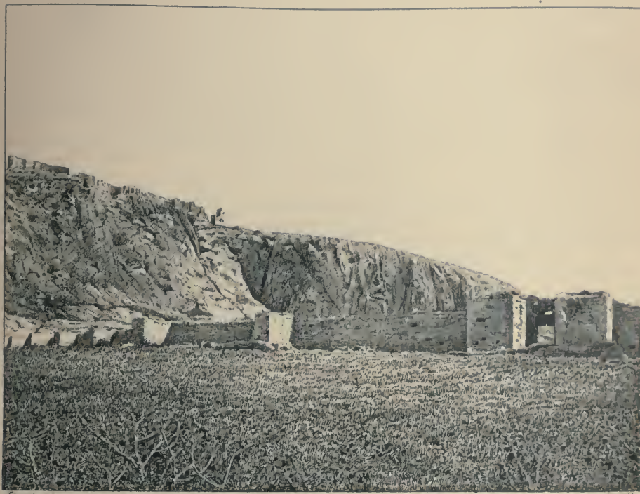
Anazarbe. Portions de l'enceinte et du château bâti sur la croupe du Kouinda, d'après une photographie inédite prise en 1875 par M. B. Mandrot.
