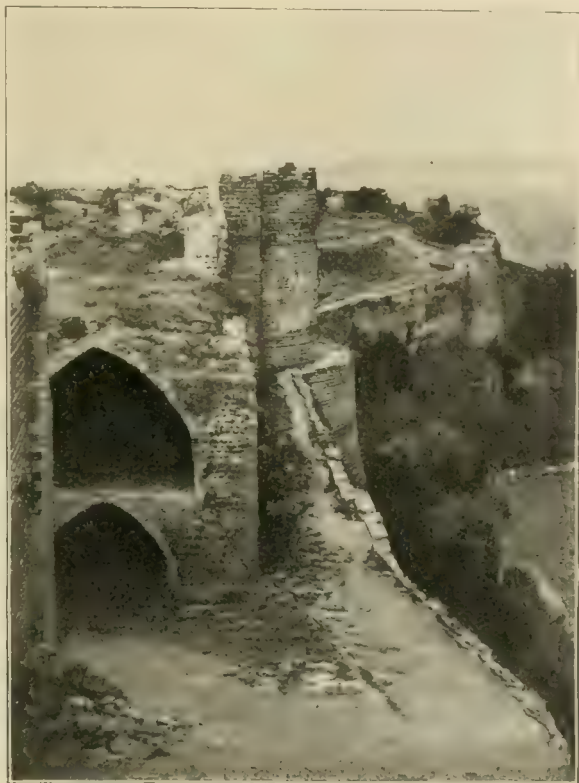
FORTERESSE DE MARGAT. Face est, montrant le chemin de ronde contourant les tours, l'escarpe et la contre-escarpe du fosse et les magasins souterrains entre les deux enceintes. — (Photo communiquée par M. M. van Berchem.)
